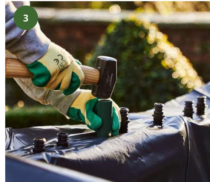
**Fixieren Sie die Schutzfolie mit den Dübeln:** Hämmern Sie die Dübel in die vorletzte Holzblockreihe, wodurch Sie die Schutzfolie an Ihrem WoodBlocX-Produkt befestigen.
