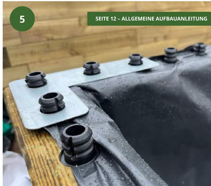
**Installieren Sie die Winkelplatten:** Verwenden Sie den Dübelschutz, um die Winkelplatten in Position zu hämmern.
