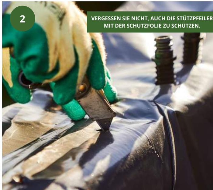
**Bringen Sie die Schutzfolie in Position:** Schneiden Sie die Schutzfolie etwas ein, damit Sie die Dübel hindurch stecken können.
