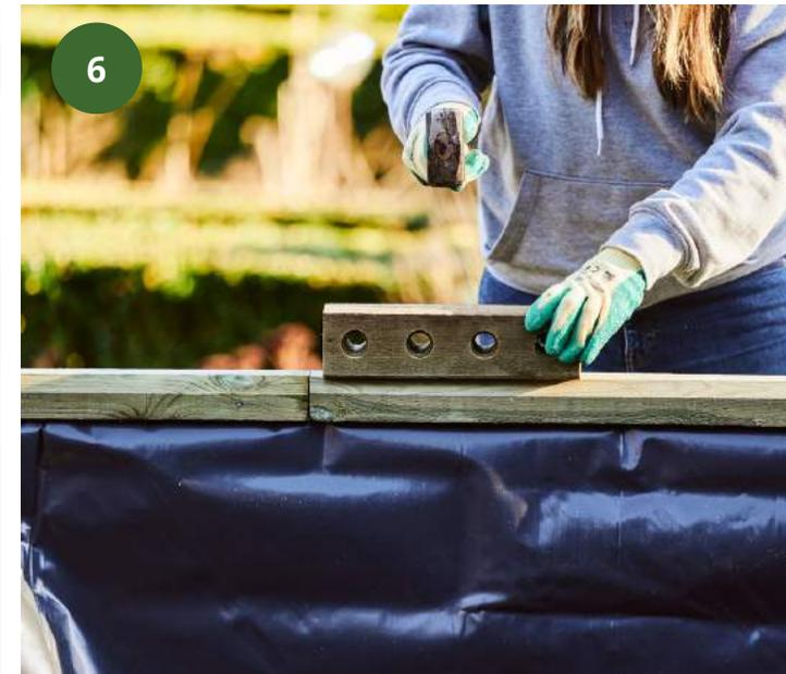
**Montieren Sie die oberste Holzblockreihe:** Am besten verwenden Sie dafür einen übriggebliebenen Holzblock, um das Holz der obersten Holzblockreihe zu schützen. **GESCHAFFT!**
